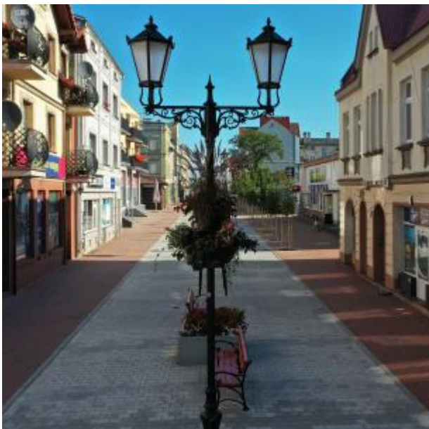
Królewska po remoncie 2025
