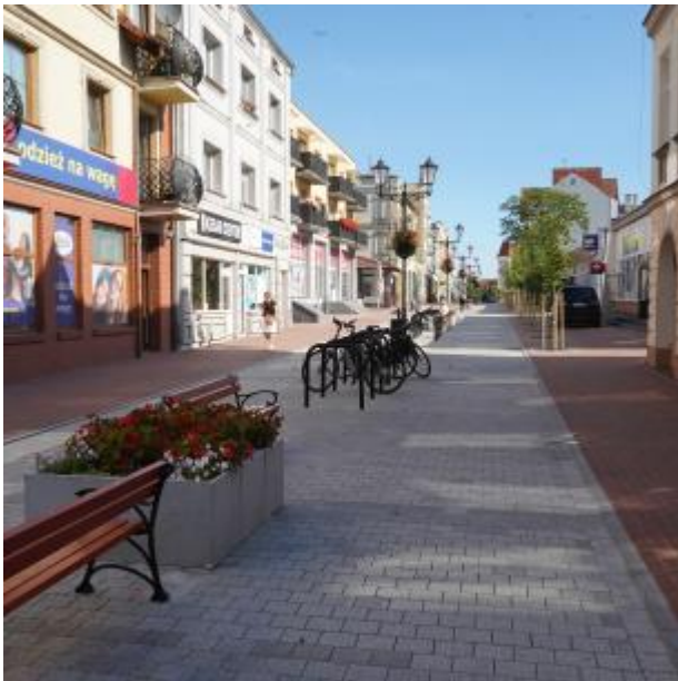
Królewska po remoncie 2025
