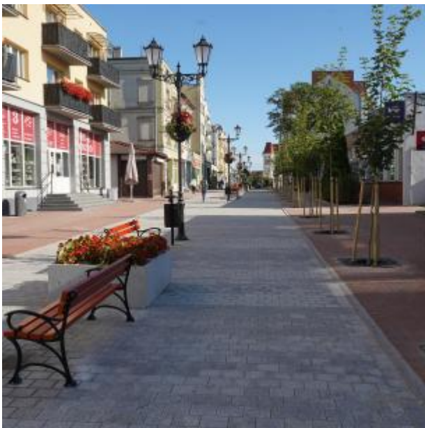
Królewska po remoncie 2025
