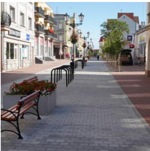
Królewska po remoncie 2025
