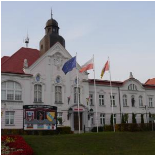
budynek Urzędu Gminy - dawna preparanda
