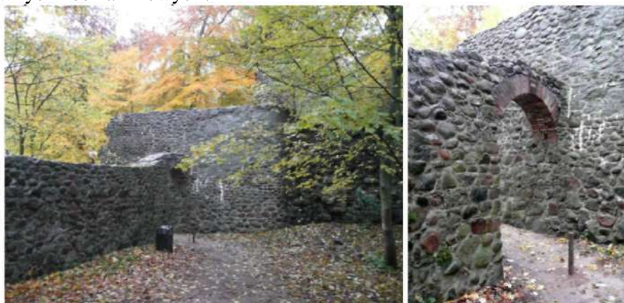
Zachowane mury IV przedzamcza z tzw. Bramą Luizy oraz wieżą obronną
